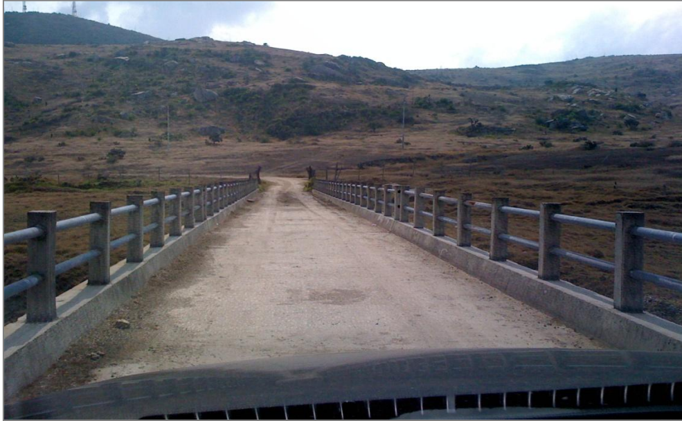
Fotografía 17 - Vía Alicachín para acceso a la plataforma del Túnel de Emergencia.
