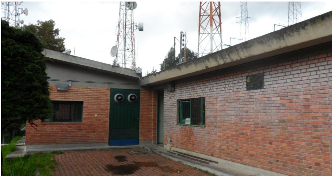
CERRO SUBA - CASETA DE EQUIPOS PROPIEDAD EAAB
