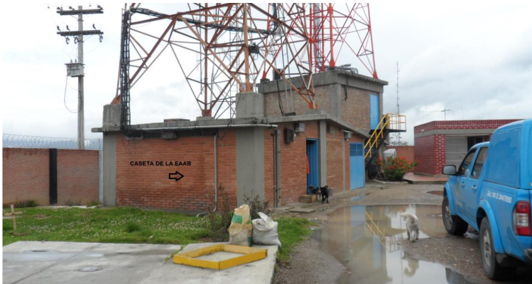
SIERRA MORENA - CASETA DE EQUIPOS PROPIEDAD EAAB
