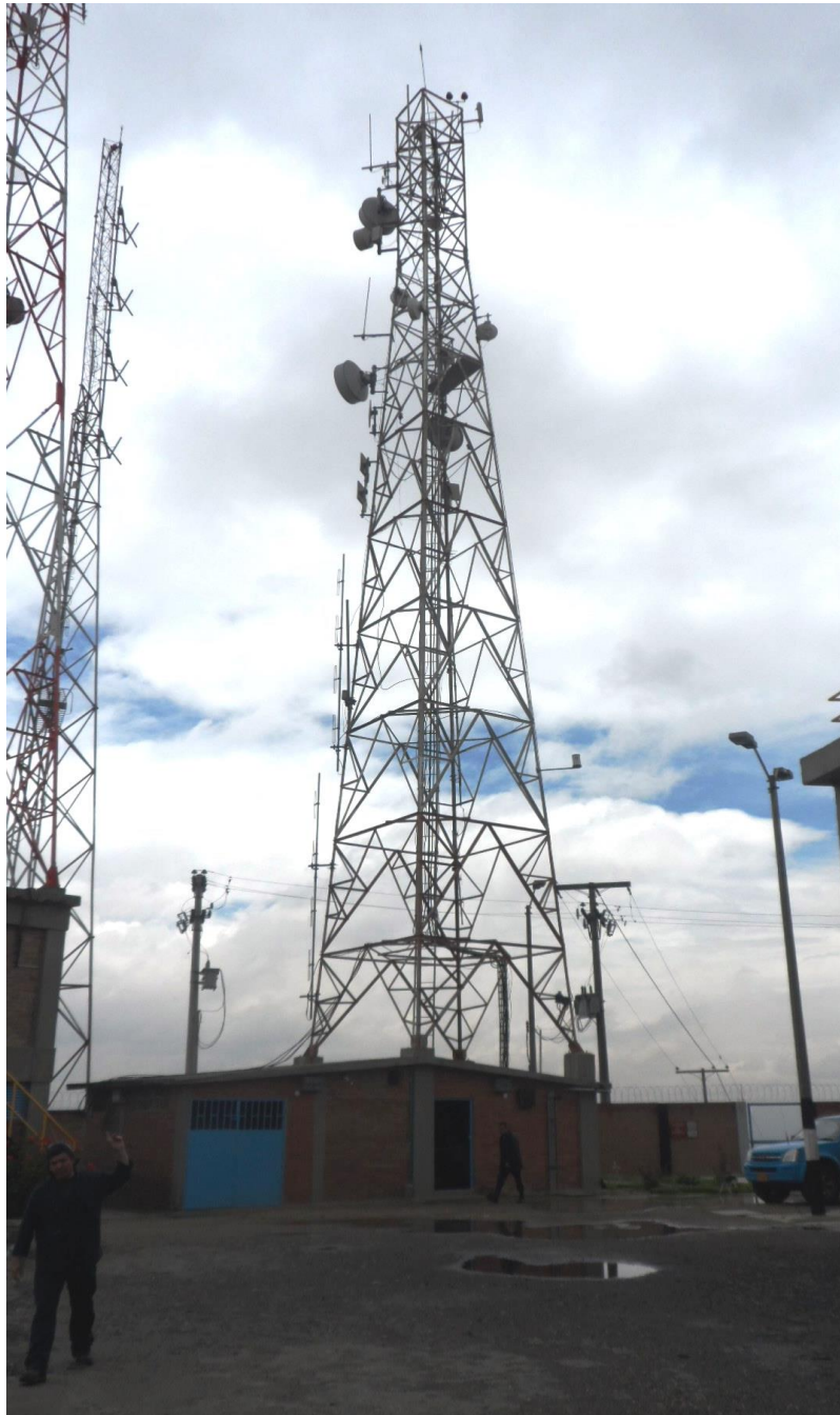
SIERRA MORENA - TORRE AUTOSOPORTADA 30 M - CUADRADA
