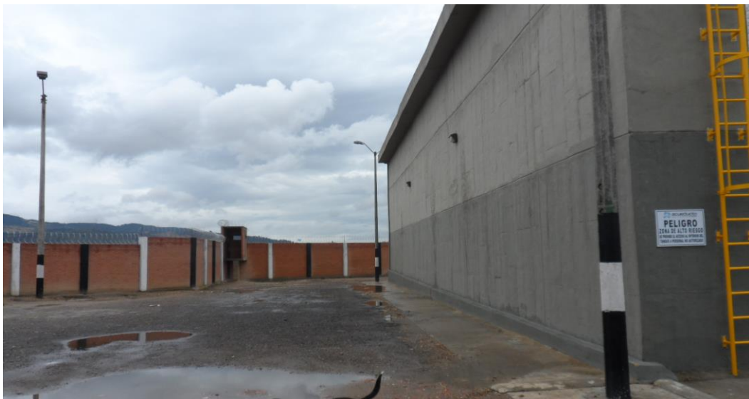
SIERRA MORENA - TANQUE ALMACENAMIENTO DE AGUA
