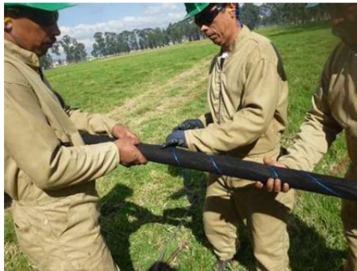
Figura 8-2 Tubo perforado recubierto por geotextil
