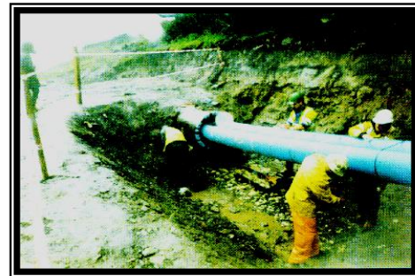
4. Proceso de inserción de la tubería.
