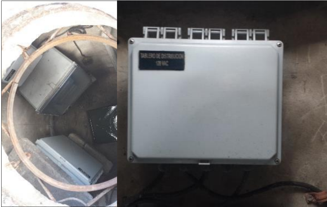
Fuente: Registro fotográfico propio ABESAN LTDA, Octubre 2016
