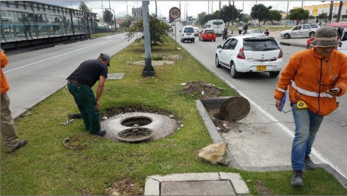
Fuente: Registro fotográfico propio ABESAN LTDA, Octubre 2016
