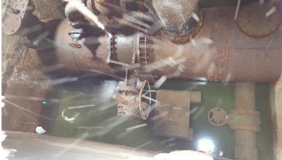
FOTO No. 13 INTERIOR CÁMARA V44
