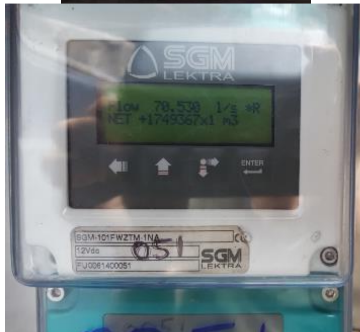
Fuente: Registro fotográfico propio ABESAN LTDA, Octubre 2016
