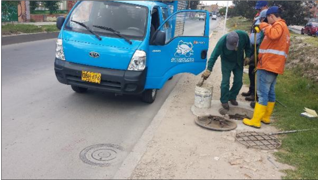
Fuente: Registro fotográfico propio ABESAN LTDA, Octubre 2016
