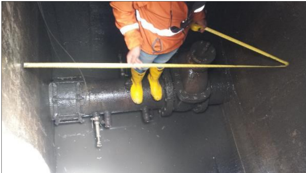
Fuente: Registro fotográfico propio ABESAN LTDA, Octubre 2016
