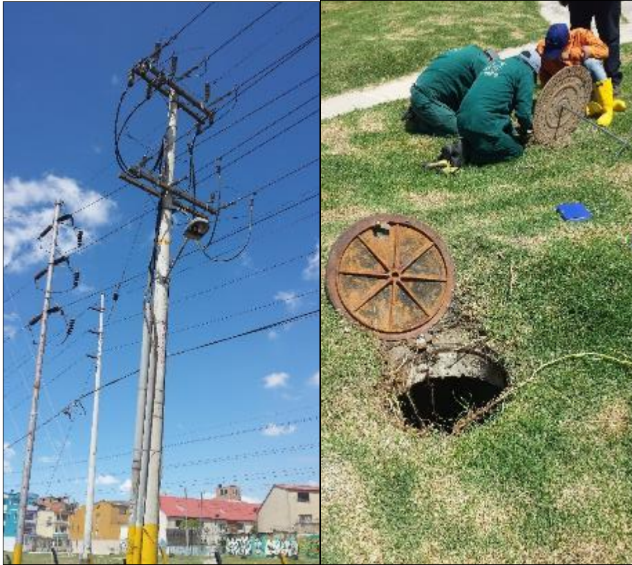
Fuente: Registro fotográfico propio ABESAN LTDA, Octubre 2016
