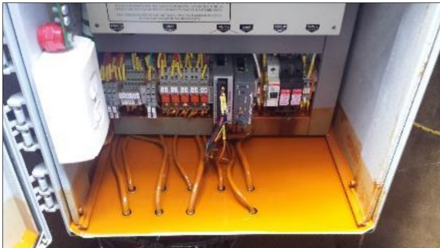
Fuente: Registro fotográfico propio ABESAN LTDA, Octubre 2016
