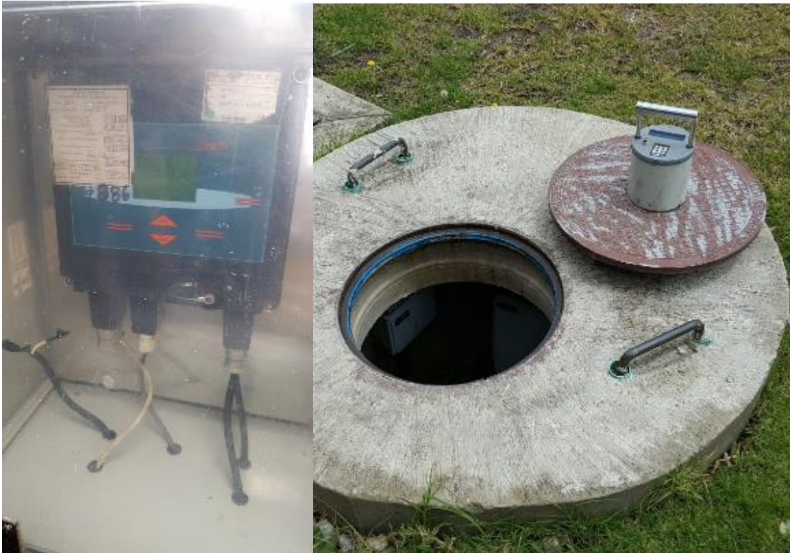
Fuente: Registro fotográfico propio ABESAN LTDA, Octubre 2016
