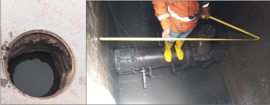
Fuente: Registro fotográfico propio ABESAN LTDA, Octubre 2016
