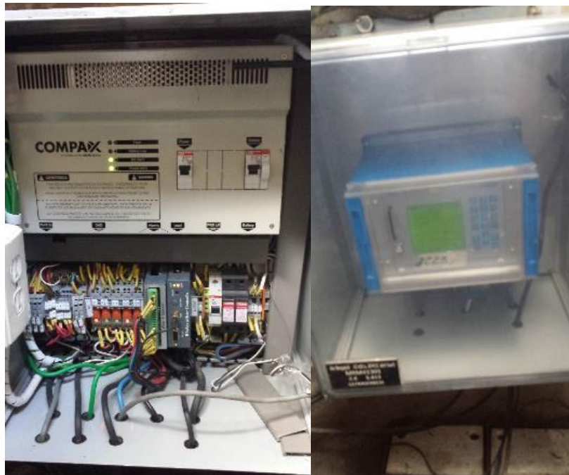
Fuente: Registro fotográfico propio ABESAN LTDA, Octubre 2016
