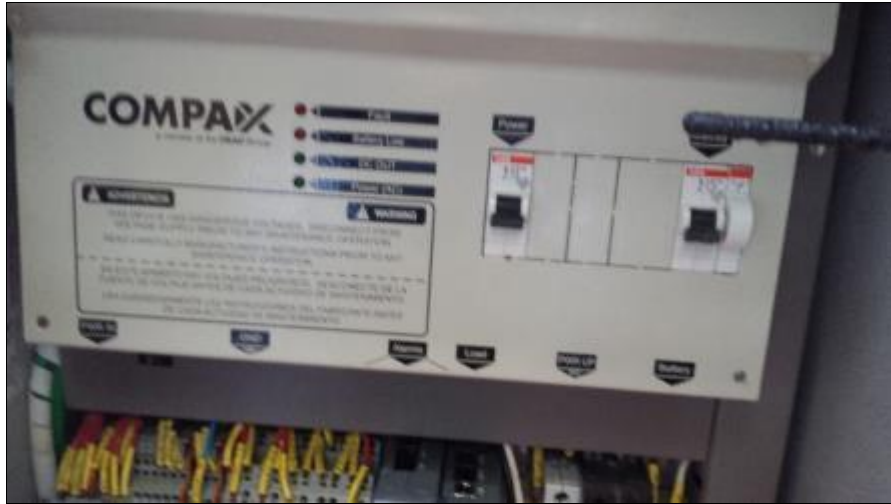
Fuente: Registro fotográfico propio ABESAN LTDA, Octubre 2016
