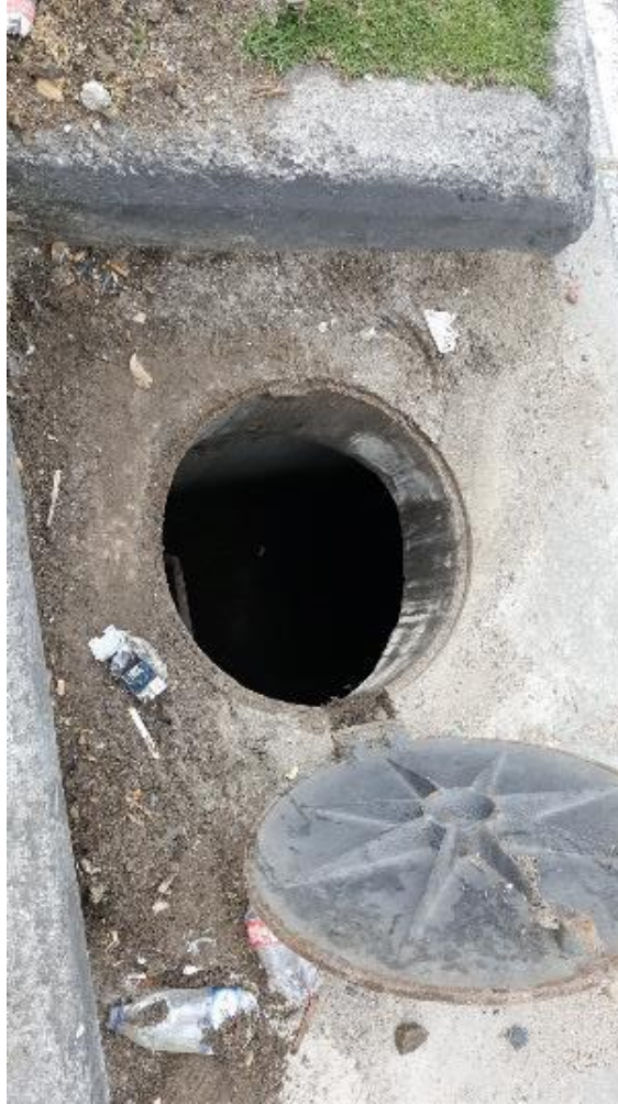
Fuente: Registro fotográfico propio ABESAN LTDA, Octubre 2016
