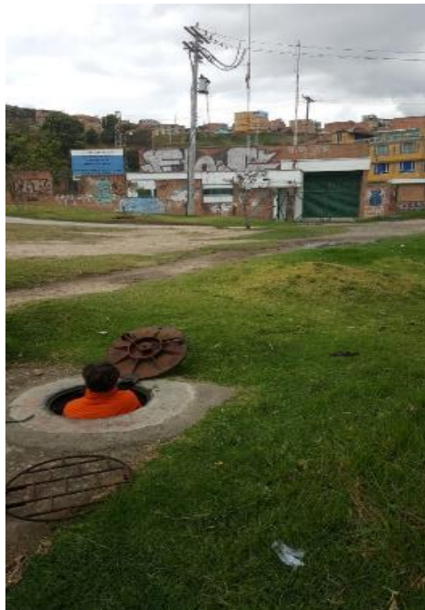
Fuente: Registro fotográfico propio ABESAN LTDA, Octubre 2016
