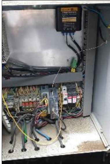
Fuente: Registro fotográfico propio ABESAN LTDA, Octubre 2016
