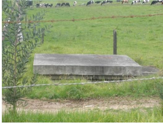
Figura 21. Cámara derivación de la línea de 78" Tibitoc-Casablanca la línea de 24" conducción hacia Tocancipá.
