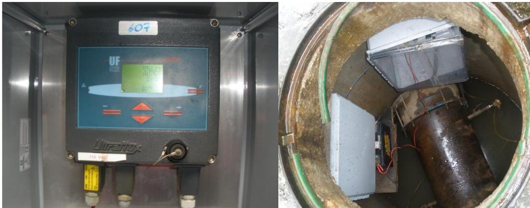
*Figura 14 y Figura 15. Macromedidor con su respectiva cámara de accesorios, instalado sobre la línea que se dirige hacia el municipio de Chía.*
