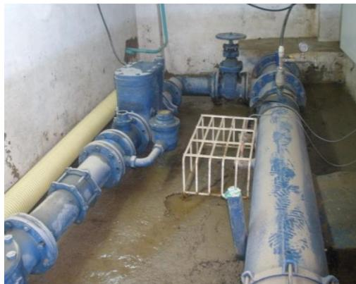
*Figura 20. Cámara actual de válvulas reductoras de presión sobre la línea de conducción hacia el municipio.*
