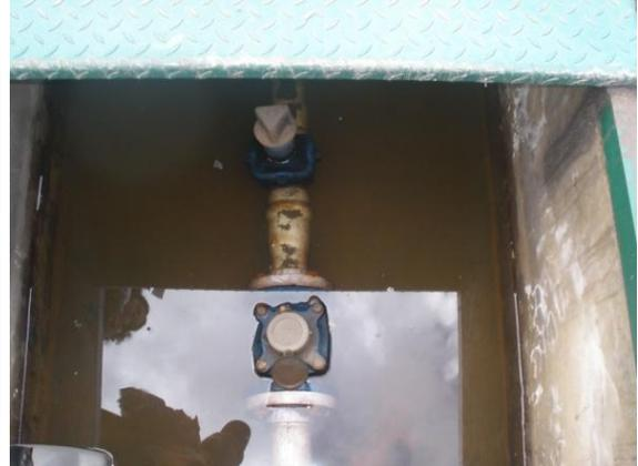
Figura 25. Cámara de accesorios de la línea en 8"
