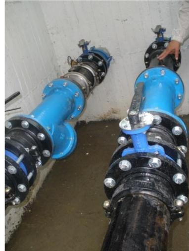
*Figura 18 y Figura 19. Nueva Cámara de válvulas reductoras de presión sobre la línea paralela a la actual línea de conducción hacia el municipio de Tocancipá.*
