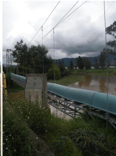
*Figura 17. Línea de conducción de 12"*
