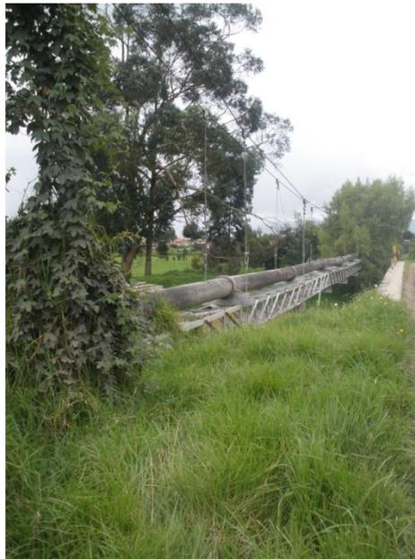
*Figura 16. Línea de conducción de 12" en H.D. en P.V.C.*
