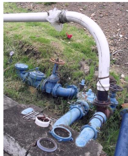
*Figura 38. Válvulas de entrada de la línea de la EAAB E.S.P. a la PTAP de Madrid.*
