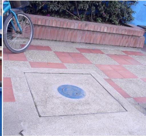
*Figura 46. Cámara de macromedidor de línea de conducción hacia Mosquera.*
