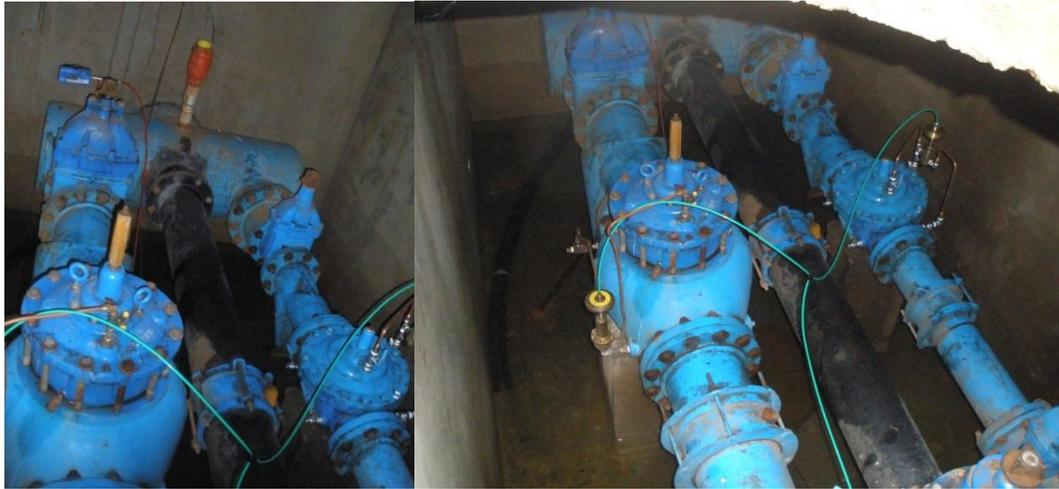
*Figura 12 y Figura 13. Cámara de válvulas reductoras de presión de la línea de conducción hacia el municipio de Chía.*
