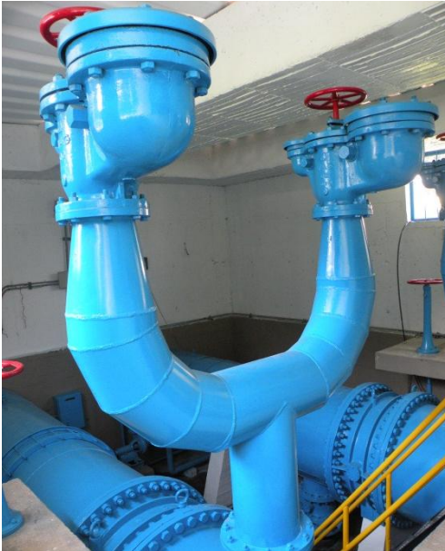
Figura 10. Ramales de salida T. Casablanca hacia línea de 78" Tibitoc-Casablanca
