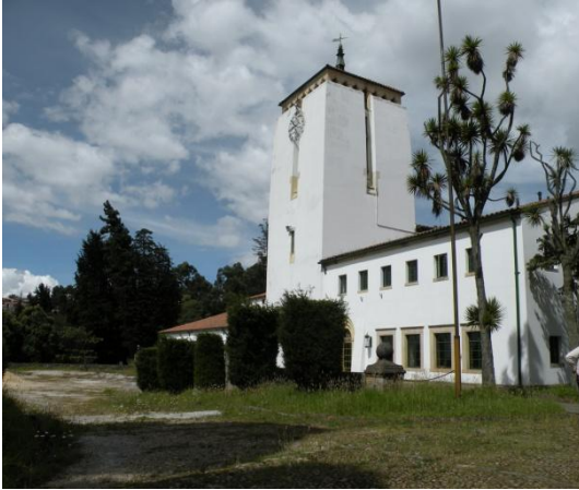
Figura 7. Planta de tratamiento Vitelma
