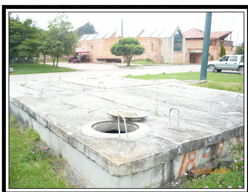
FOTO No. 1 Vista Externa de la Cámara
