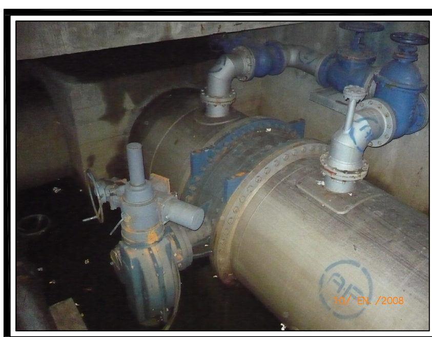
FOTO No. 2 Vista Interna de la Cámara
