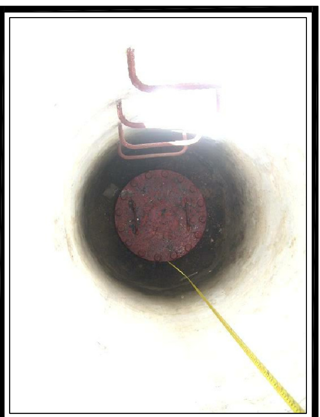
FOTO No. 2 Vista Interna de la Cámara
