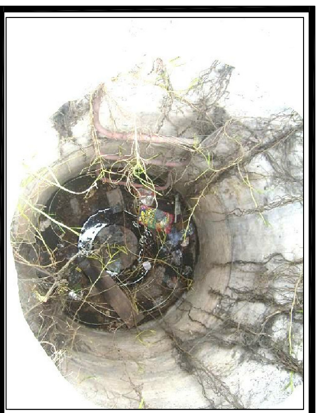
FOTO No. 2 Vista Interna de la Cámara
