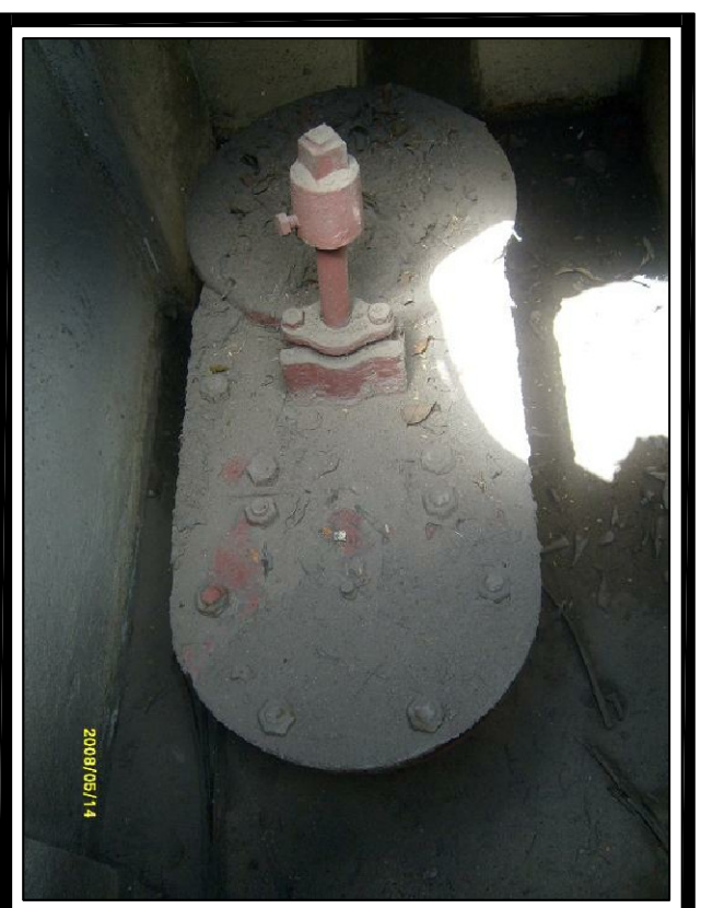
FOTO No. 2 Vista Interna de la Camara
