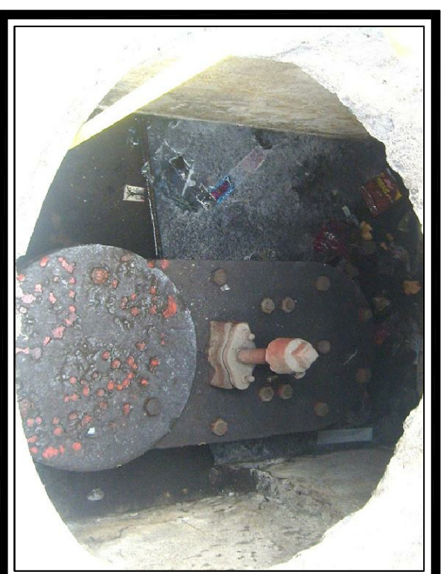
CÁMARA VENTOSA CORTE B-B
