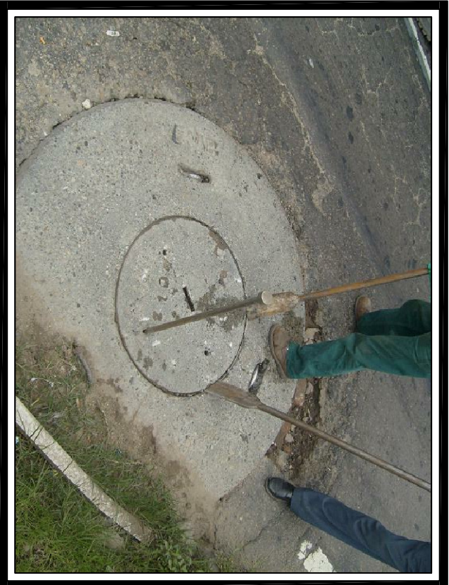
FOTO No. 1 Vista Externa de la Cámara
