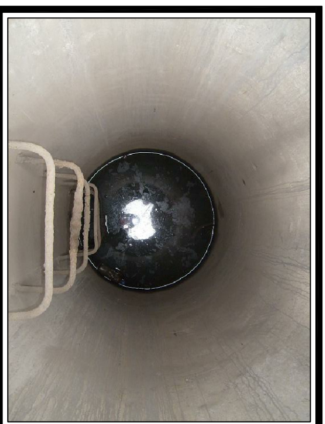
FOTO No. 2 Vista Interna de la Cámara
