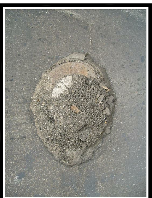
FOTO No. 2 Vista Externa de la Camara
