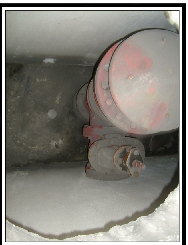
FOTO No. 2 Vista Interna de la Camara
