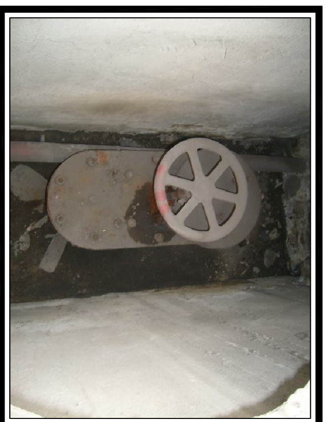
FOTO No. 2 Vista Interna de la Camara
