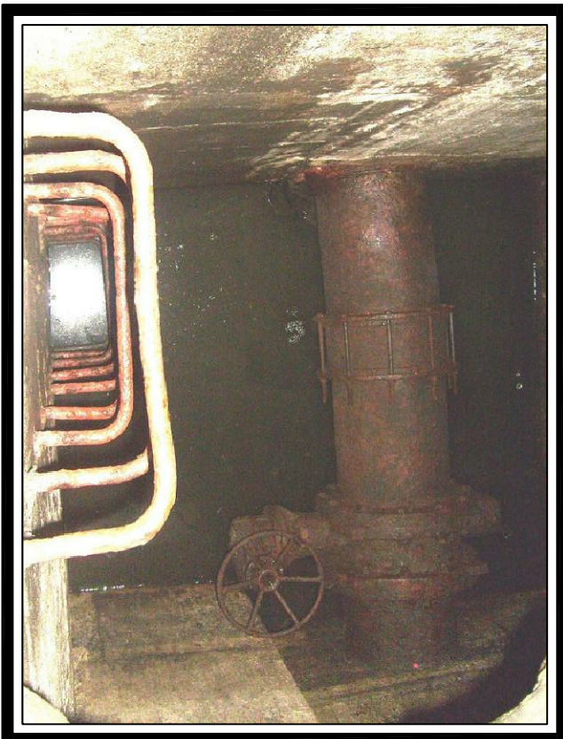
FOTO No. 2 Vista Interna de la Camara
