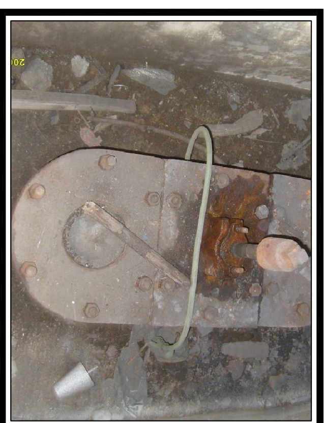
FOTO No. 2 Vista Interna de la Camara
