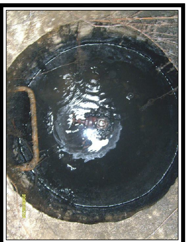
FOTO No. 2 Vista Interna de la Camara
