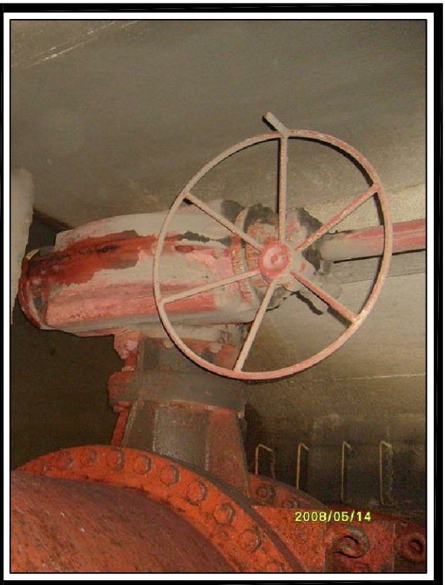
FOTO No. 4 Vista Interna de la Cámara (Valvula)
