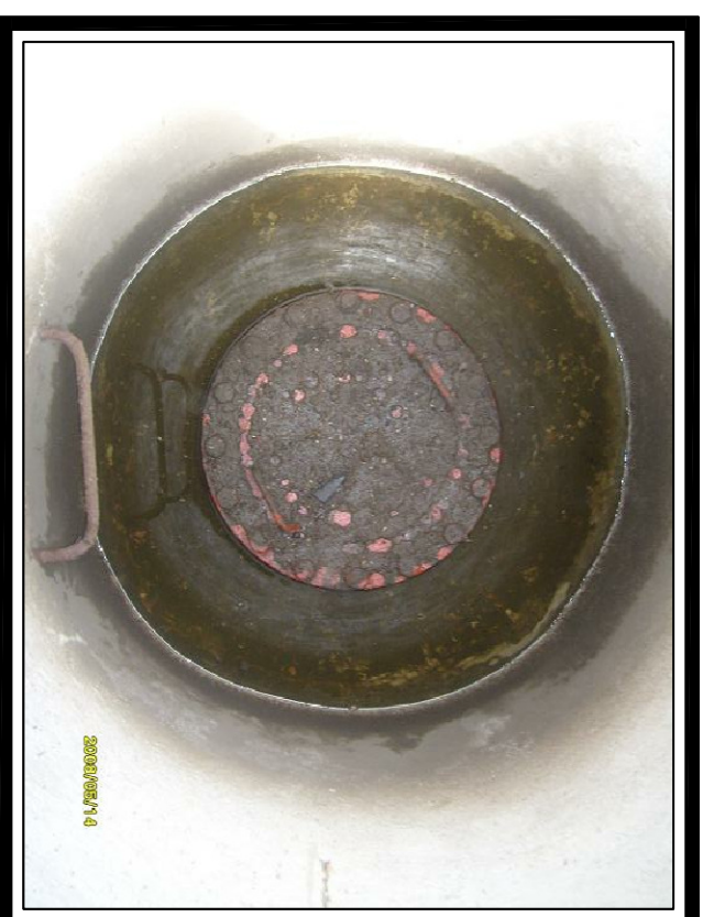
FOTO No. 2 Vista Interna de la Camara
