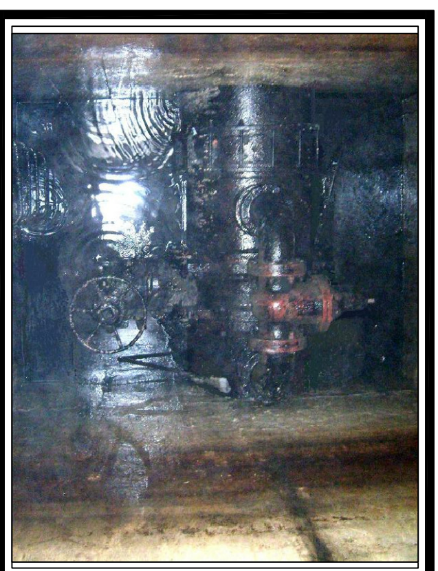
FOTO No. 2 Vista Interna de la Cámara
