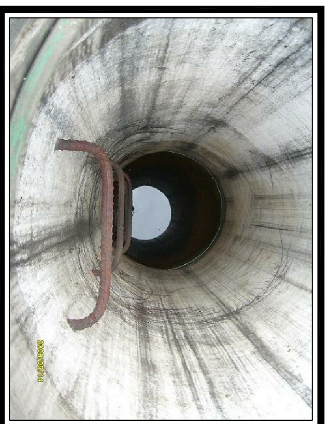
FOTO No. 2 Vista Interna de la Camara
