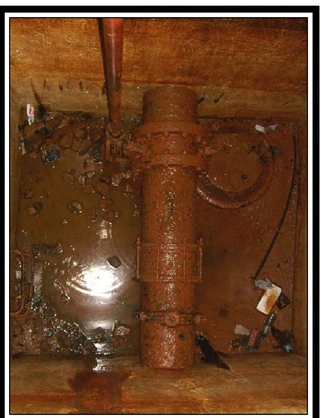
FOTO No. 2 Vista Interna de la Camara
