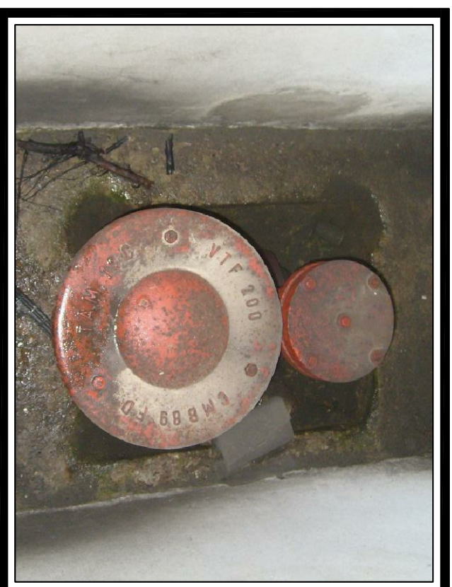
FOTO No. 2 Vista Interna de la Cámara
