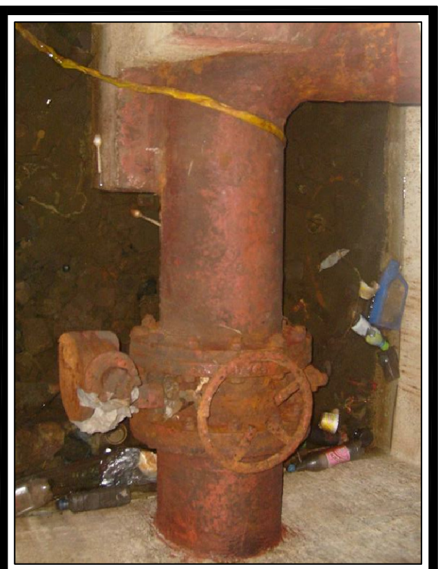
FOTO No. 2 Vista Interna de la Cámara
