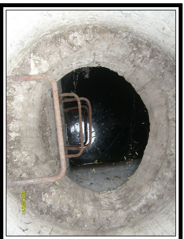
FOTO No. 2 Vista Interna de la Camara
