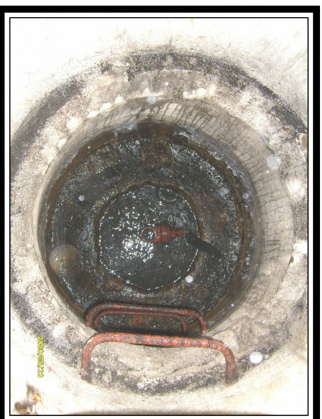
FOTO No. 2 Vista Interna de la Camara
