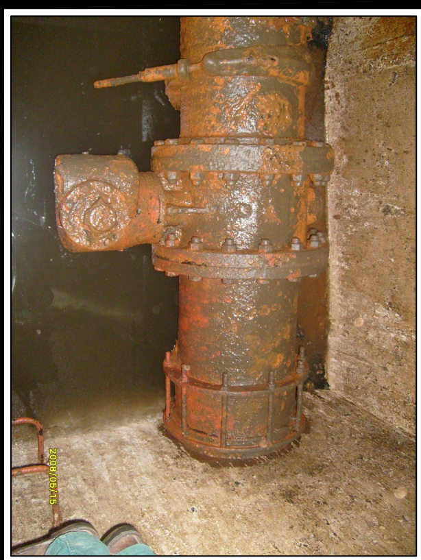
FOTO No. 2 Vista Interna de la Cámara
