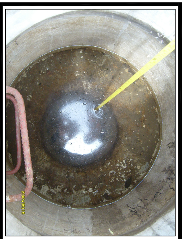
FOTO No. 2 Vista Interna de la Camara
