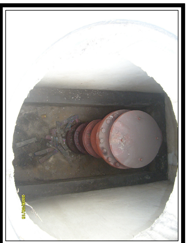
FOTO No. 2 Vista Interna de la Cámara
