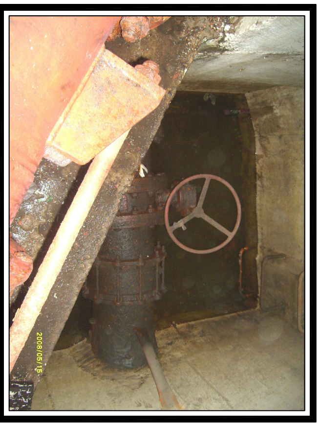
FOTO No. 2 Vista Interna de la Camara
