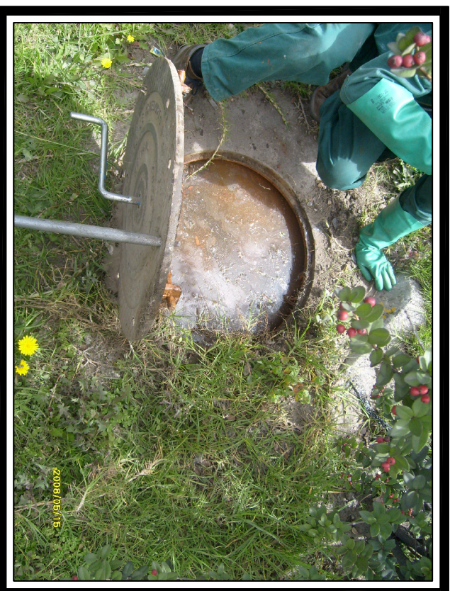
FOTO No. 2 Vista Interna de la Camara
