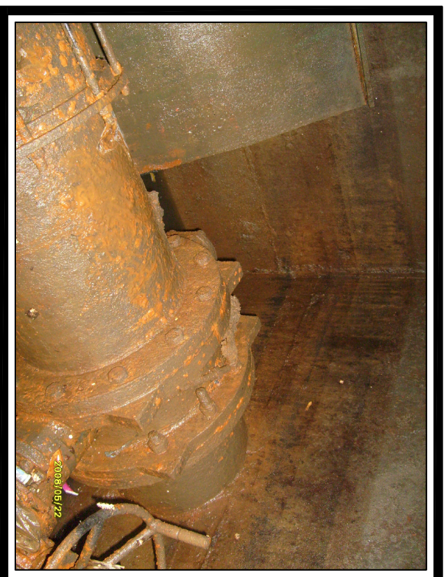
FOTO No. 2 Vista Interna de la Camara
