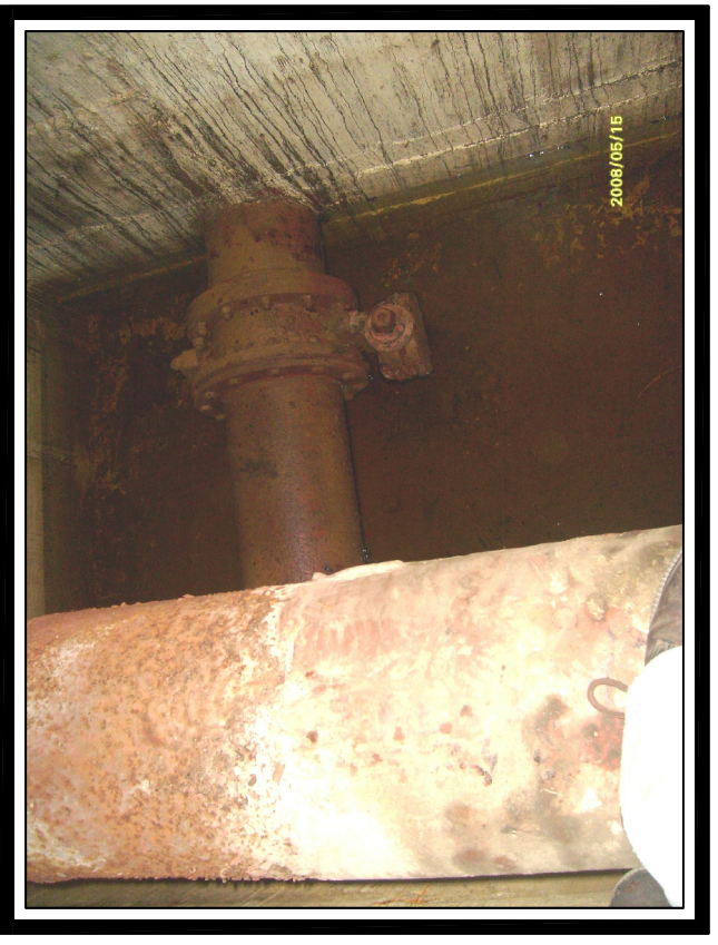
FOTO No. 2 Vista Interna de la Camara
