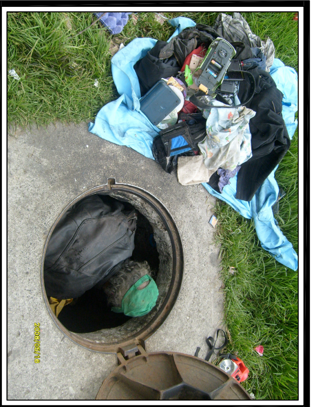
FOTO No. 1 Vista Externa de la Cámara
