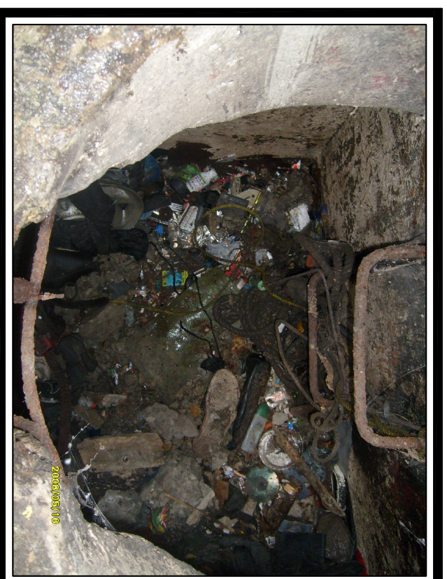
FOTO No. 2 Vista Interna de la Cámara
