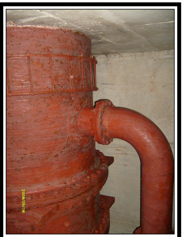
FOTO No. 2 Vista Interna de la Cámara
