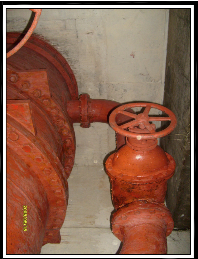
FOTO No. 3 Vista Interna de la Cámara
