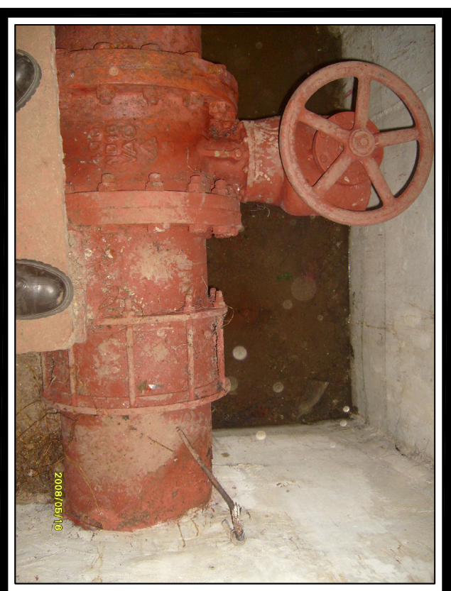
FOTO No. 5 Vista Interna de la Cámara
