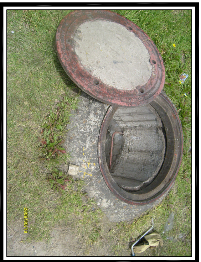
FOTO No. 1 Vista Externa de la Cámara
