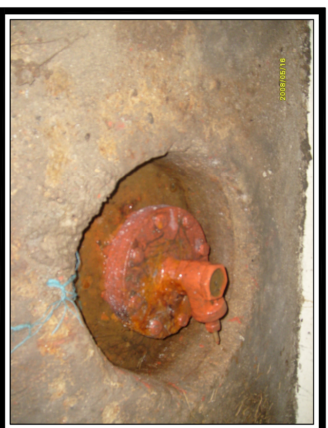
FOTO No. 2 Vista Interna de la Cámara
