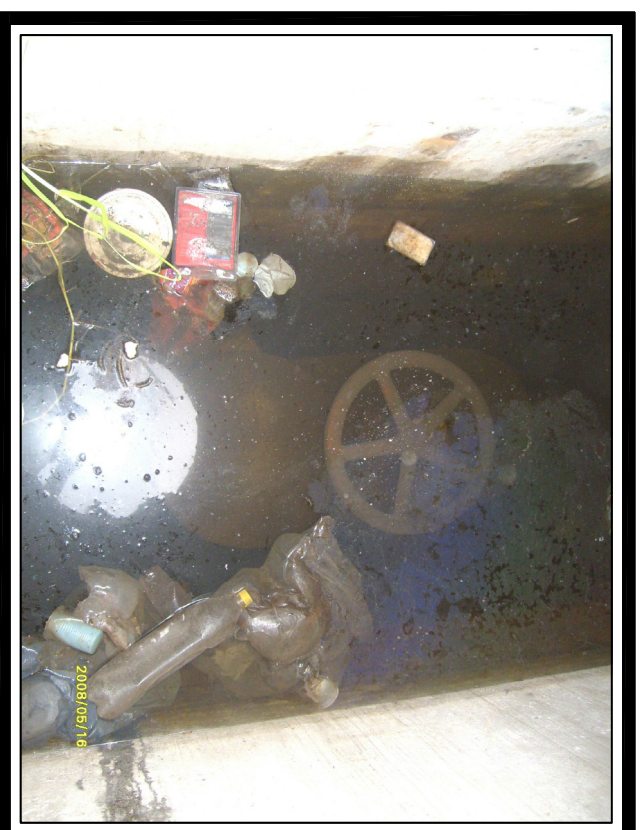
FOTO No. 2 Vista Interna de la Camara
