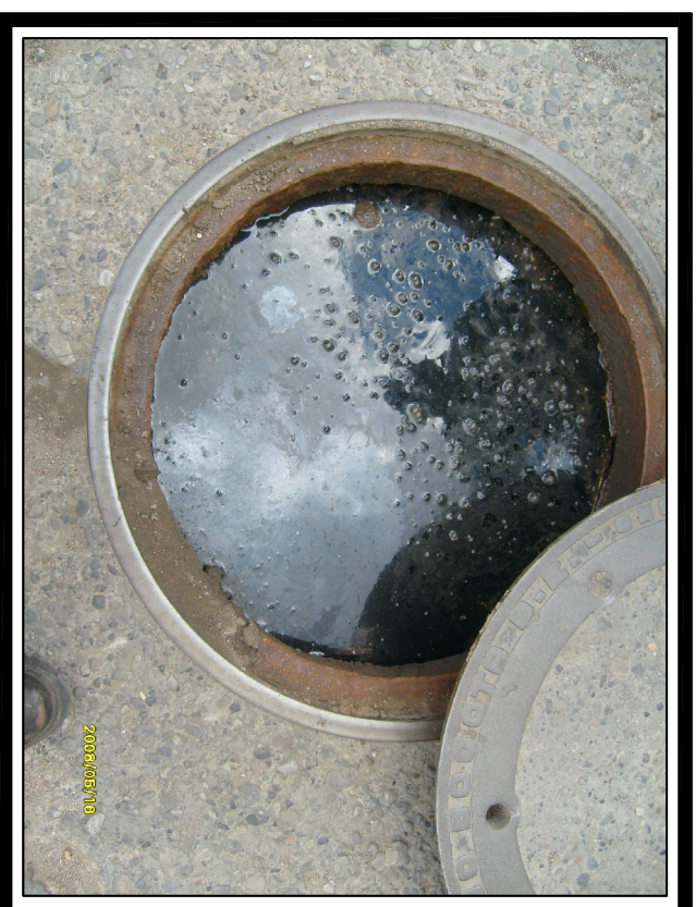
FOTO No. 2 Vista Interna de la Camara
