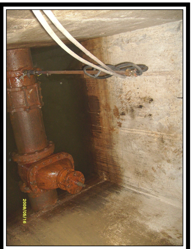
FOTO No. 2 Vista Interna de la Camara
