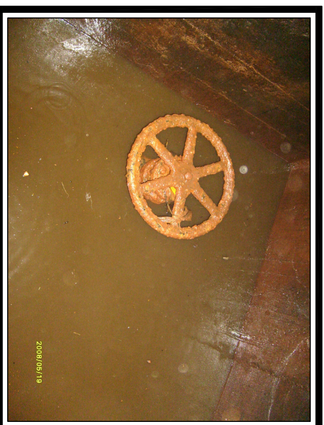
FOTO No. 2 Vista Interna de la Camara
