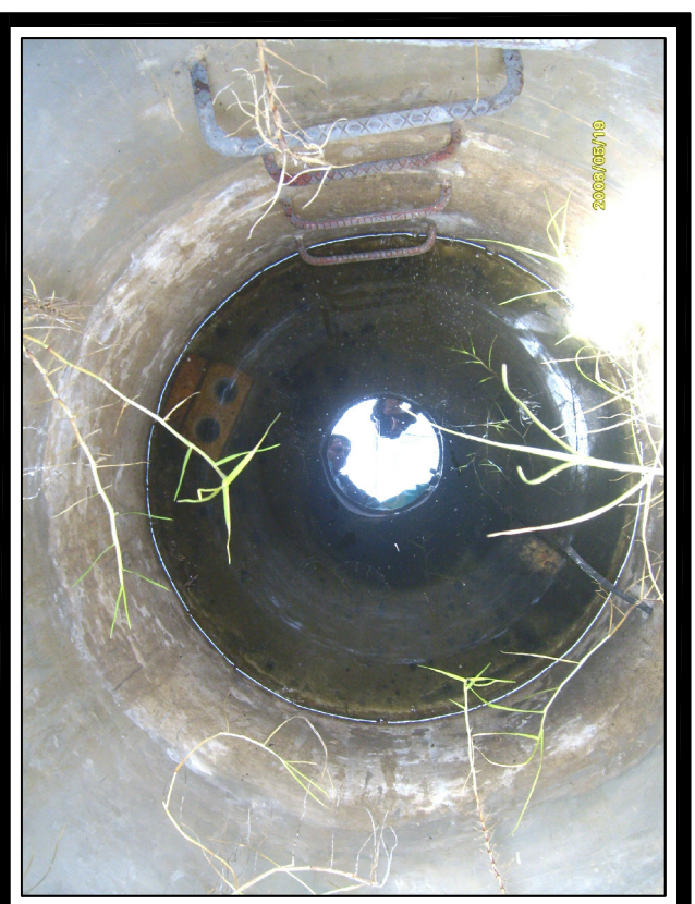
FOTO No. 2 Vista Interna de la Cámara
