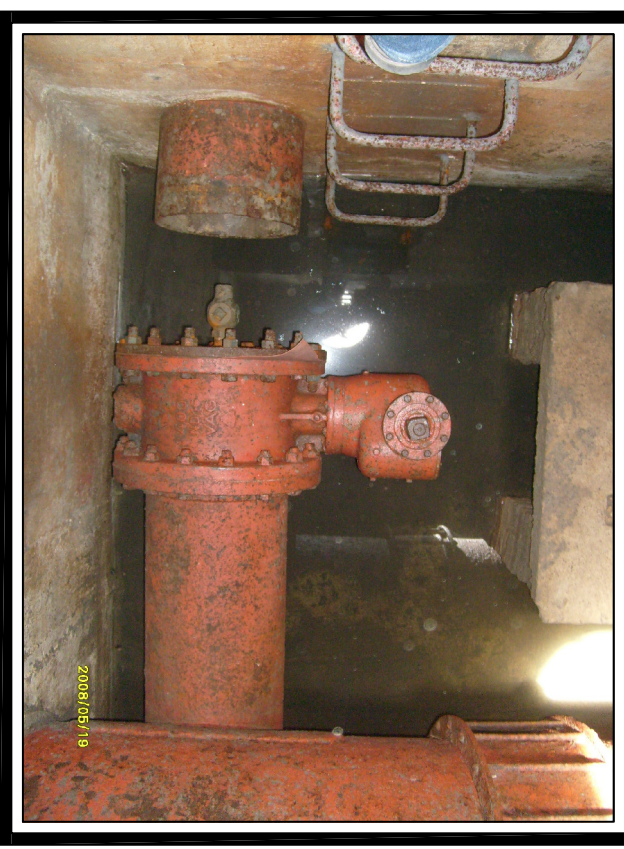
FOTO No. 4 Vista Interna de la Cámara
