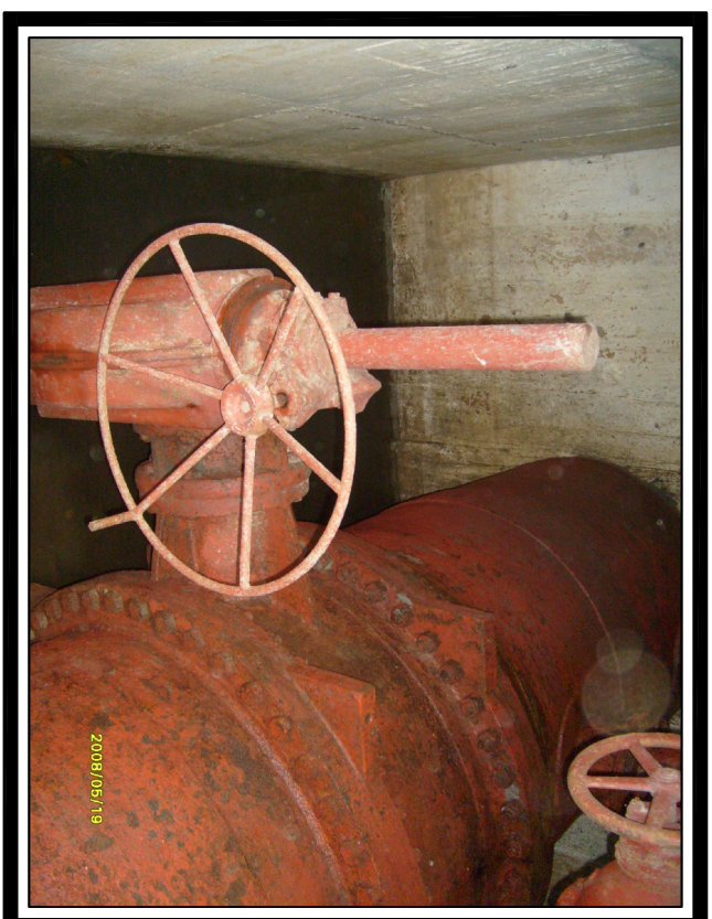
FOTO No. 5 Vista Interna de la Cámara
